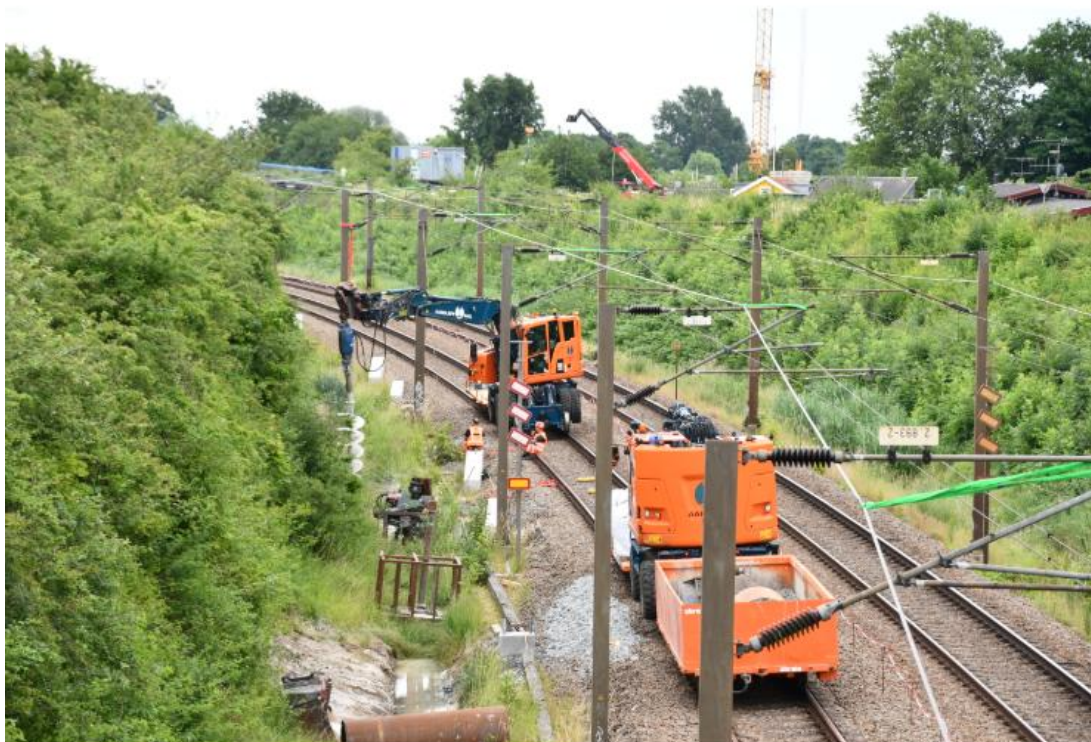
Der arbejdes med etablering af kørestrømsfundamenter
