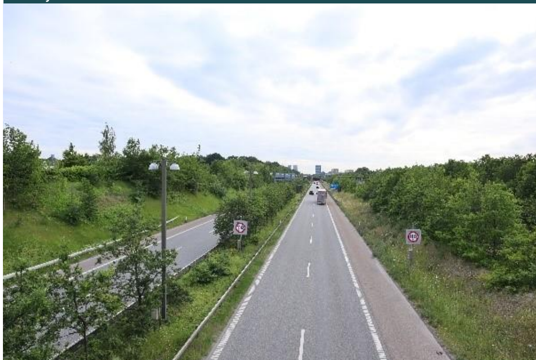
FIGUR 14.4 Øresundsmotorvejen set fra Amager Landevej med kig mod overdækningen ved Tårnby Station
