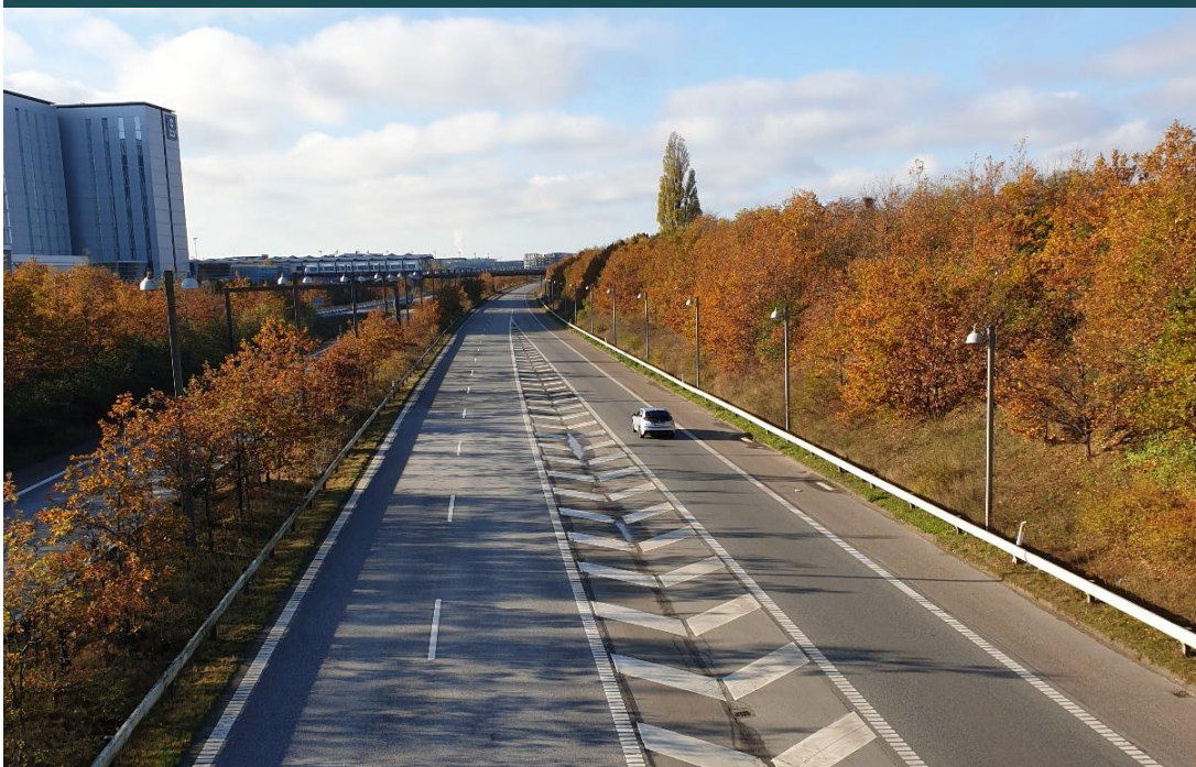
FIGUR 5.11 Øresundsmotorvejen set mod vest fra overføringen af Amager Strandvej
