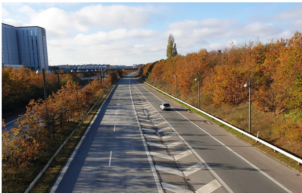
Figur 1.1 Øresundsmotorvejen set mod vest fra overføringen af Amager Strandvej
