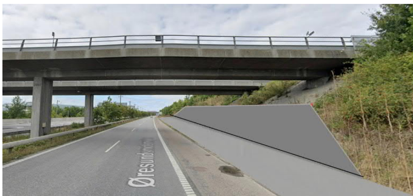
Figur 4.12.4-4 Udvidelse under metro
