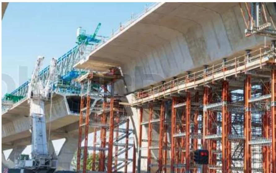
Figur 15 Bro efter afforskalling, understøttet på stillads
