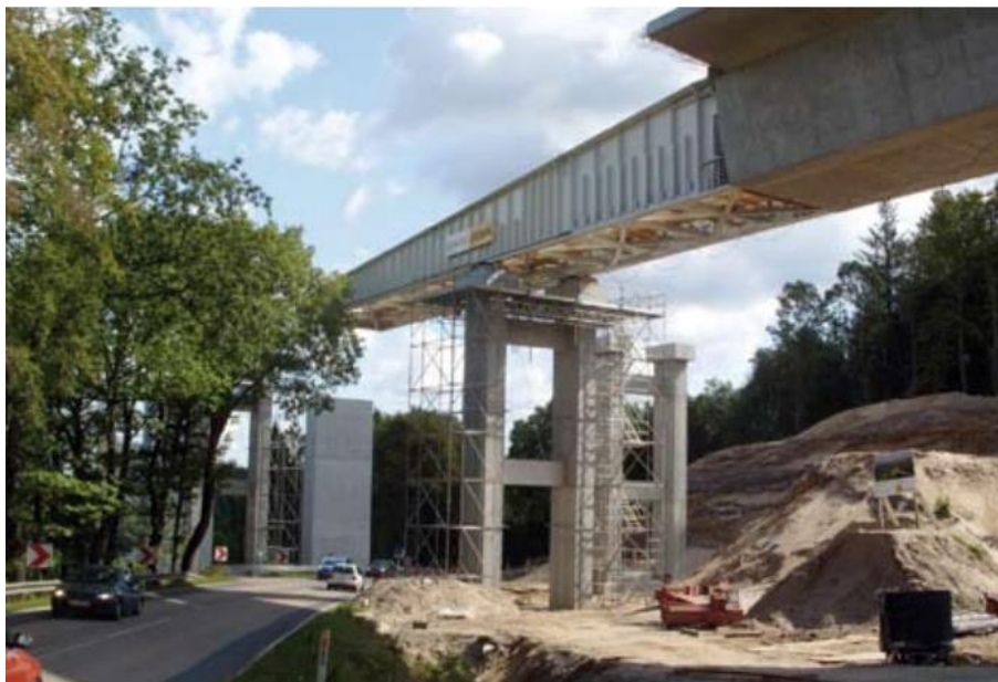
Figur 12 Funder Ådal, successiv fremskubning med fremskubningsnæse til venstre.
