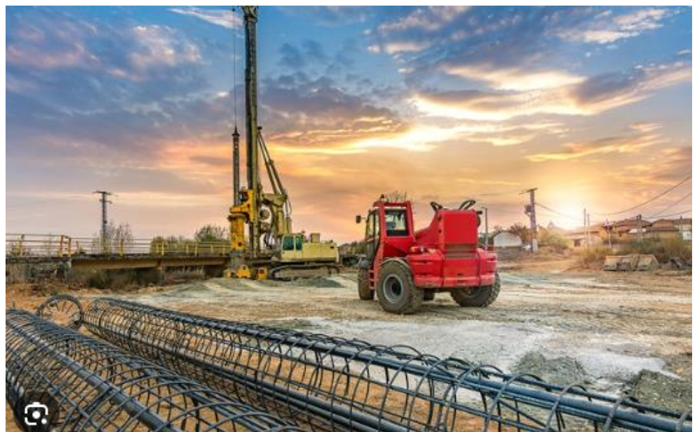
Figur 14 Udførelse af borede pæle
