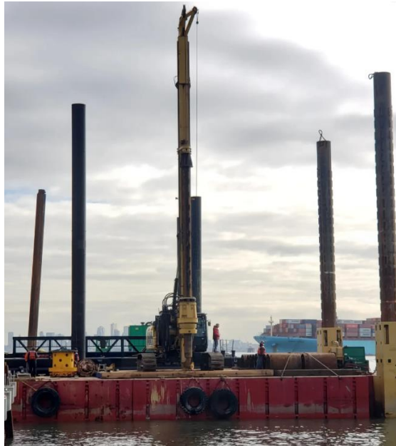
Figur 7 Pram med boreudstyr for pæle.
