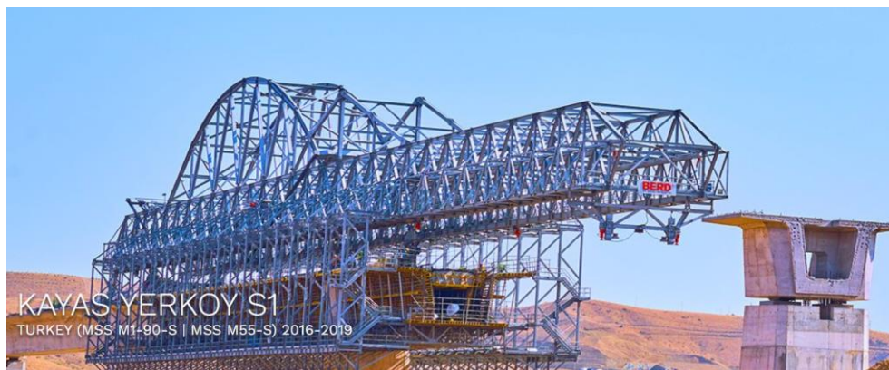
Figur 13 Kayas Tyrkiet, MSS.
