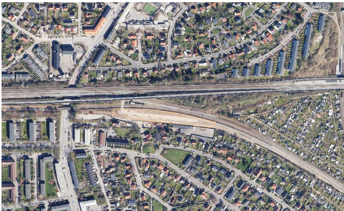
Figur 4: Oplags- og læsseplads for banetekniske komponenter ved Vigerslev Godsvej
