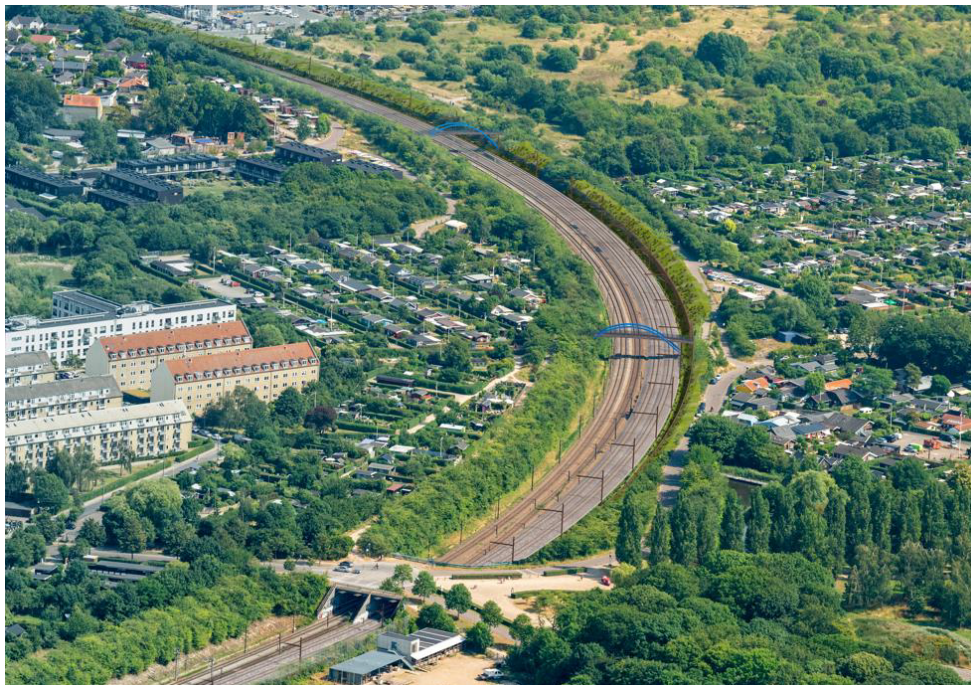
Figur 1: Visualisering af Løsning O-4, med stibroer indtegnet med blå og med ung beplantning.
