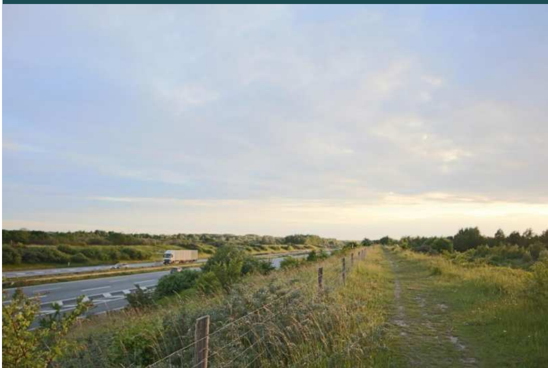
FIGUR 14.11 Eksisterende forhold. Trampesti på toppen af den nordlige terrænvold. Kig mod vest
